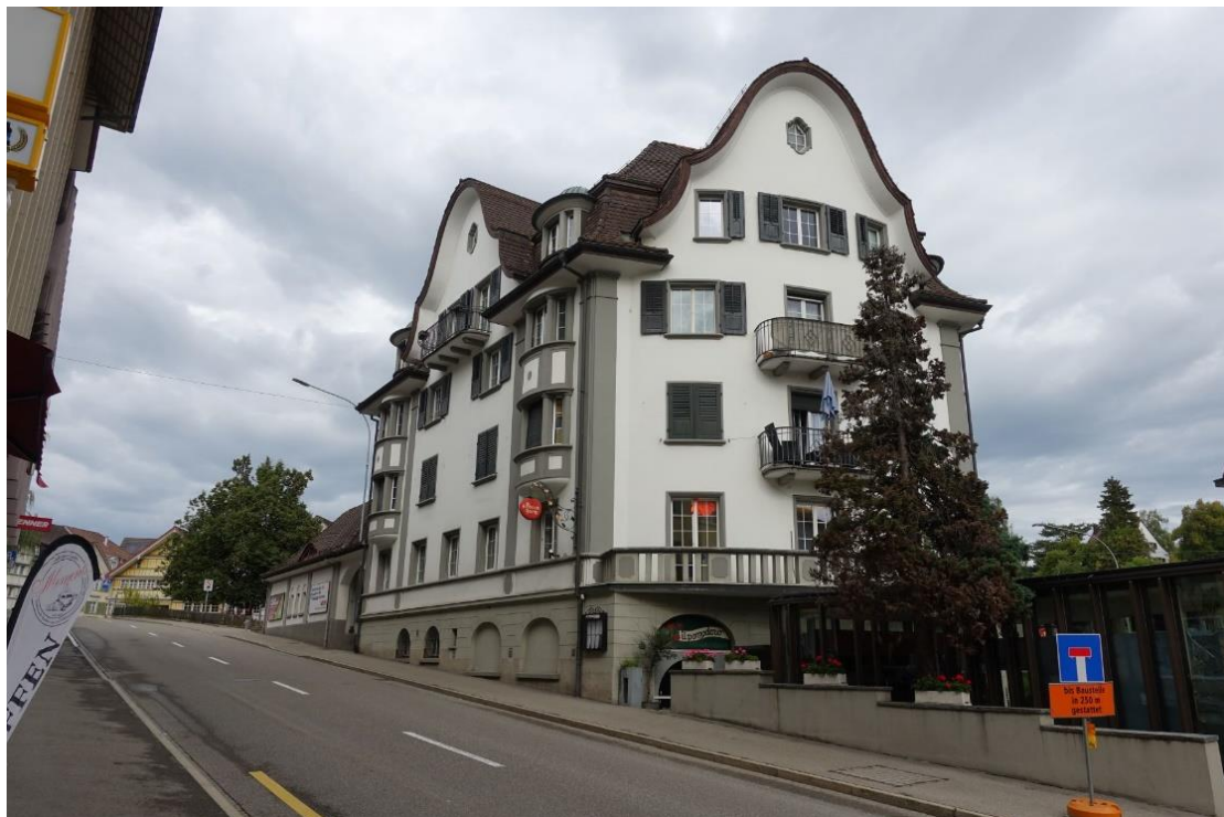
Aktueller Zustand der alten Bahnhofstrasse Herisau
